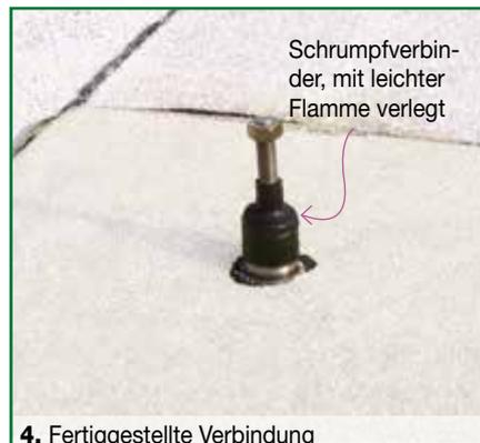
Schrumpfverbinder, mit leichter Flamme verlegt
