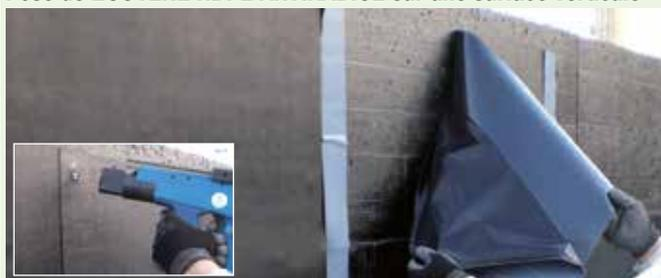
Pose sur une surface verticale et détail de la fixation
