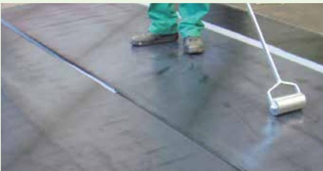
3. Drücken Sie schließlich zugunsten einer besseren Haftung die gesamte Oberfläche mit der Rolle an.
