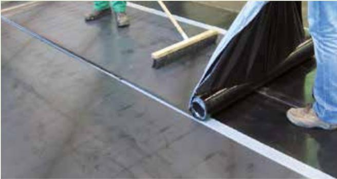
1. Üben Sie während der Verlegung von ECOTENE HDPE ANTIRADICE derartig Druck aus, dass die Bildung von Luftblasen vermieden wird (beispielsweise anhand der Verwendung einer Strebhbürste)
