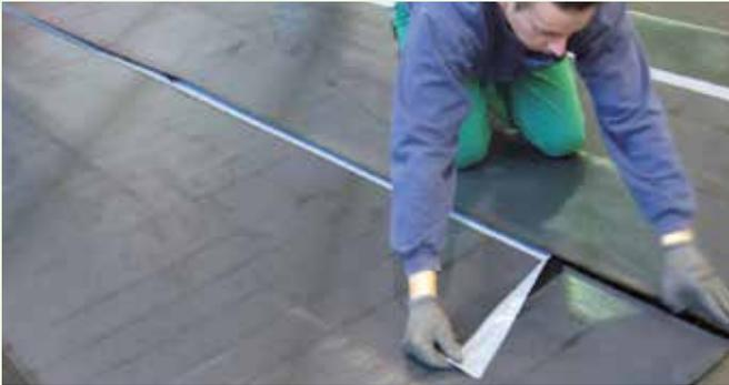
2. Ziehen Sie die silikonierten Folie von der Seitenkante ab und verkleben Sie den selbstklebenden seitlichen Überlappungsrand
