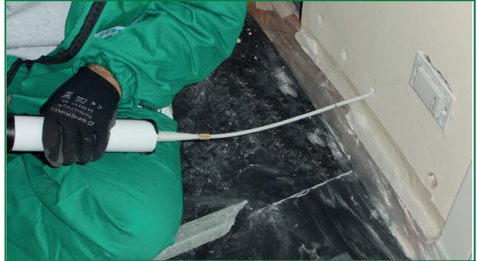
Das Gel mit handelsüblichen Skelettpistolen vom Lochboden beginnend einspritzen und den gesamten Hohlraum füllen, wobei die letzten 2 cm freigelassen werden, um sie anschließend mit schnell abbindendem Mörtel, z.B. FASTCEM, zu schließen.
