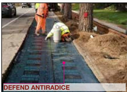
**DEFEND ANTIRADICE ROAD 15** è una membrana impermeabilizzante resistente alle radici. La caratteristica antiradice è ottenuta aggiungendo la miscela bitume distillato polimero, con specifico agente antiradice, phenoxi-fatty acid ester.
