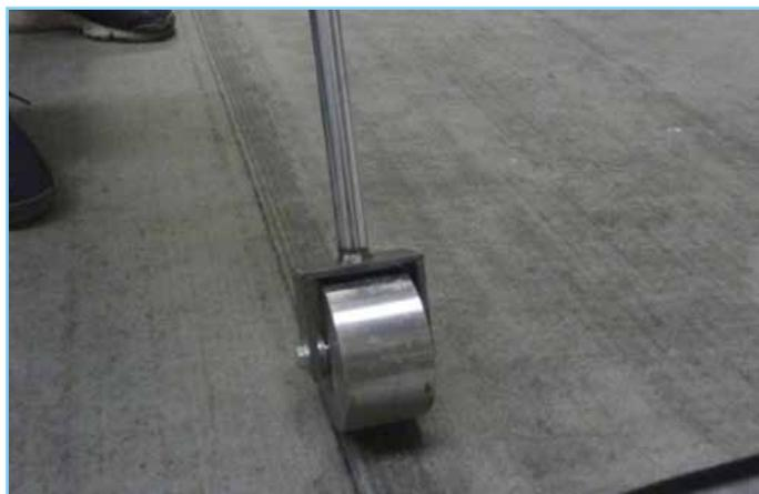
La saldatura dei sormonti di testa verrà ottenuta impiegando un saldatore ad aria calda o una fiamma leggera usando un cannello con campana di diametro non superiore a 2 cm.
