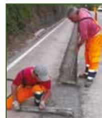
4. Una volta che si è riempito lo scavo con la malta si procederà con la posa di una fascia larga 50 cm (quanto la larghezza della zona scarificata) del geocomposito **AUTOTENE ASFALTICO ANTIPUMPING**.
