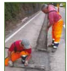
4. Auf die mit Mörtel verfüllte Grube wird ein 50 cm breiter Streifen (je nach Breite des abgefrästen Bereichs) des Geoverbundstoffs **AUTOTENE ASFALTICO ANTIPUMPING** gelegt.
