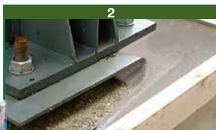
**BETON FLUID RAPID** va miscelato con acqua pulita mantenendo un rapporto acqua/cemento inferiore a 0,40. L'impasto deve essere eseguito aggiungendo la polvere all'inerte già bagnato con l'acqua (1).
