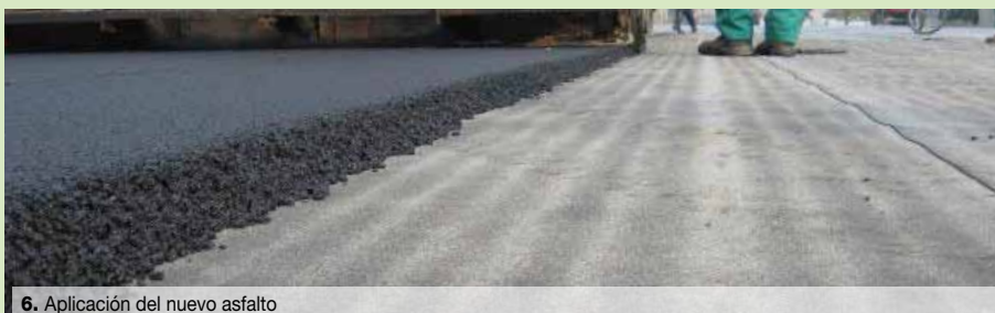
6. Aplicación del nuevo asfalto
