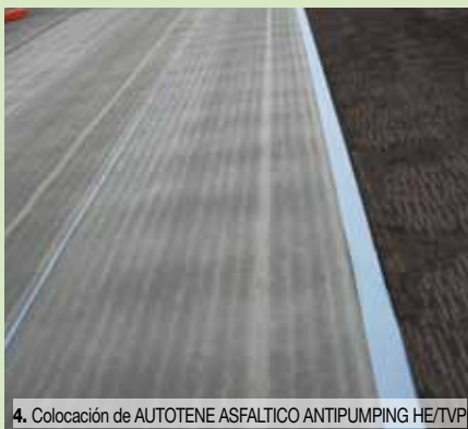
4. Colocación de AUTOTENE ASFALTICO ANTIPUMPING HE/TVP
