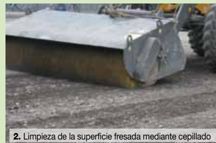
2. Limpieza de la superficie fresada mediante cepillado
