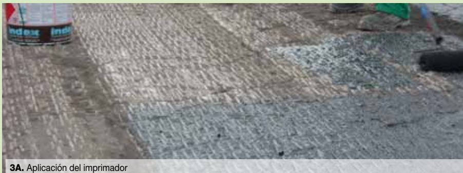
3A. Aplicación del imprimador
