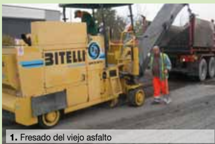
1. Fresado del viejo asfalto
