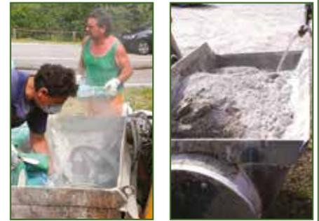
3. Der Mörtel wird über die Mischschaufel in den Aushub vergossen. Er lässt sich leicht mit einem Rüttelstampfer verdichten.
