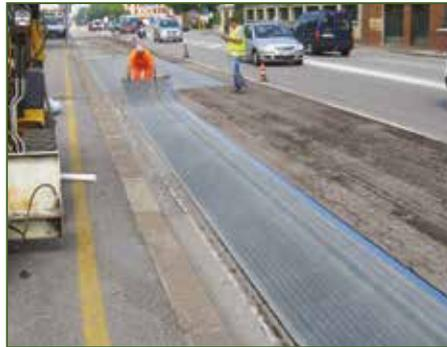
Für diesen Arbeitsgang sind mindestens zwei Facharbeiter erforderlich, die die Bahn abwechselnd an den beiden Enden ziehen, bis sie gleichmäßig und ohne Falten ausgelegt ist.
