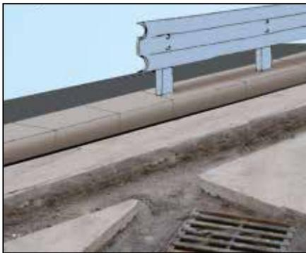
Il riempimento di scavi, tracce e trincee richiede un betoncino colabile a basso modulo elastico e di facile posa.
