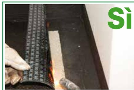
**ATTENZIONE:** è assolutamente da evitare l'inversione delle fasi di posa, posando prima la membrana ed eseguire poi i dettagli con UNOLASTIC. Un eventuale applicazione di UNOLASTIC su membrana con superficie non ardesiata porterebbe al conseguente distacco del film di UNOLASTIC.
