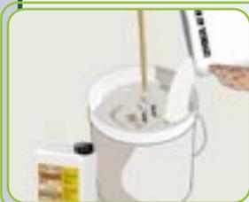
Utilizzare COVERCOL AB RAPID, oppure OSMOLASTIC AB o OSMOFLEX AB, prodotti bicomponenti a base di leganti idraulici ed elastomeri acrilici in grado di assorbire i movimenti strutturali senza lesionarsi grazie alla loro ottima flessibilità ed elasticità. Versare il lattice (componente B) nel contenitore ed aggiungere gradualmente la polvere (il componente A), mescolando con un agitatore meccanico a bassa velocità fino ad ottenere un impasto omogeneo e privo di grumi, con ottima plasticità.
