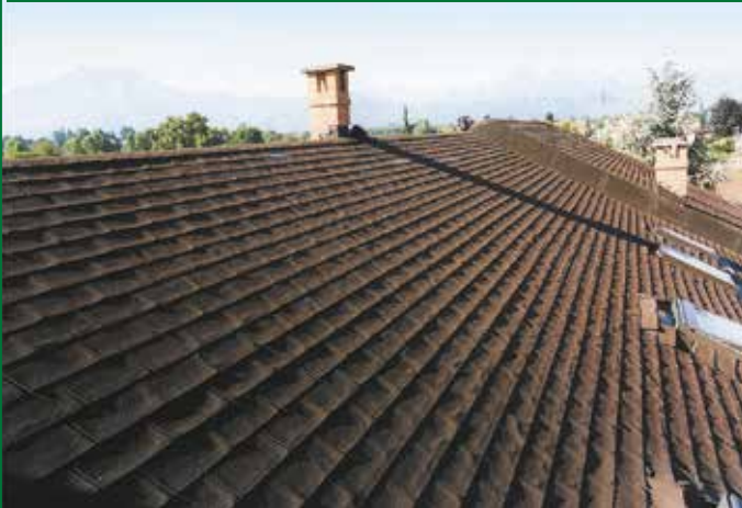
Prima: copertura con vecchie tegole bituminose
