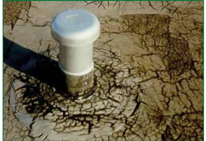
COCCODRILLATURA DI SUPERFICIE BITUMINOSE ARDESiate PER ECCESSO DI SPESSORE DI BITUME SULL'ARMATURA, MA DOPO 30 ANNI IL MANTO È ANCORA A TENUTA D'ACQUA
