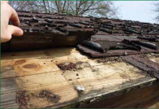
Prima: copertura con vecchie tegole bituminose
