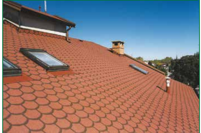
Dopo: tegole rimosse e sostituite con MINERAL DESIGN
