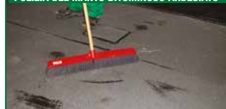
PULIZIA DEL MANTO BITUMINOSO ARDESIATO
