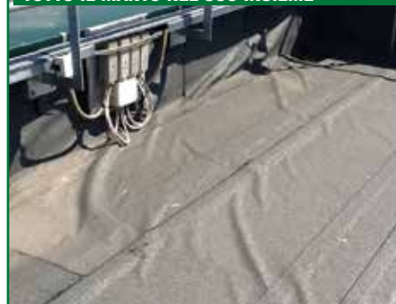
RITIRO A CALDO DELLE GIUNZIONI DI TESTA DI MEMBRANE ARMATE CON TNT DI POLIESTERE, IL FENOMENO INTERESSA OGNI FOGLIO SINGOLARMENTE
