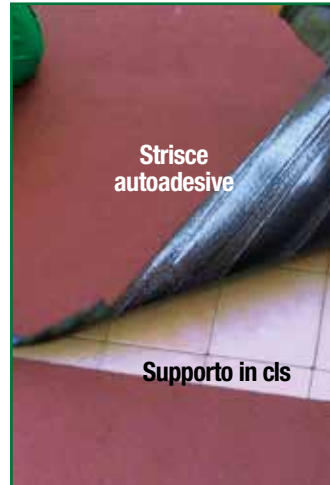
Rimozione del film siliconato
