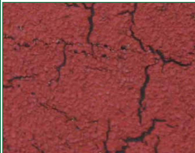
COCCODRILLATURA DI SUPERFICIE BITUMINOSE ARDESiate PER ECCESSO DI SPESSORE DI BITUME SULL'ARMATURA, MA DOPO 30 ANNI IL MANTO È ANCORA A TENUTA D'ACQUA
