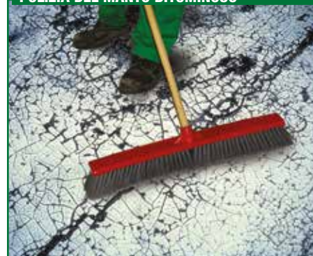
PULIZIA DEL MANTO BITUMINOSO
