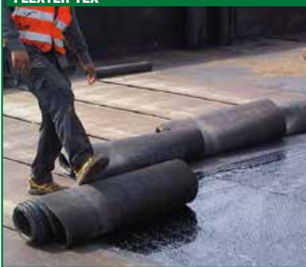
5. POSA DELL'ARMATURA RINFOTEX EXTRA
