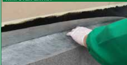
8. RIMOZIONE DEL NASTRO PROTETTIVO PRECEDENTEMENTE APPLICATO
