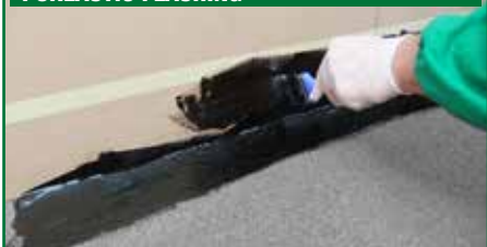
7. SECONDA MANO DI PURLASTIC FLASHING
