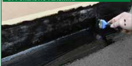
7. SECONDA MANO DI PURLASTIC FLASHING
