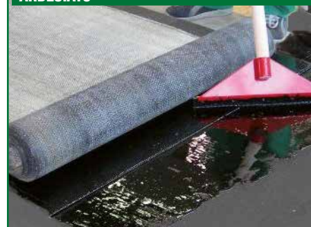
APPLICAZIONE DI FLEXTER TEX INCOLLATO CON MASTIPOL SU MANTO BITUMINOSO ARDESIATO
