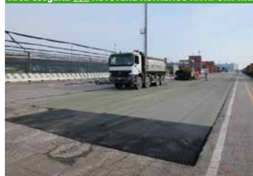
Area eseguita con AUTOTENE ASFALTICO ANTIPUMPING
