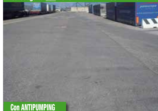
Area eseguita con AUTOTENE ASFALTICO ANTIPUMPING
