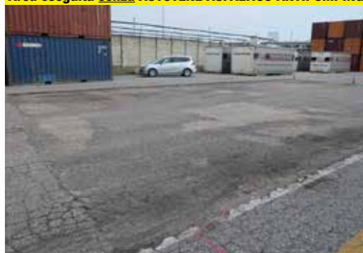
Area eseguita senza AUTOTENE ASFALTICO ANTIPUMPING
