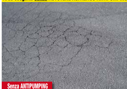
Area eseguita senza AUTOTENE ASFALTICO ANTIPUMPING
