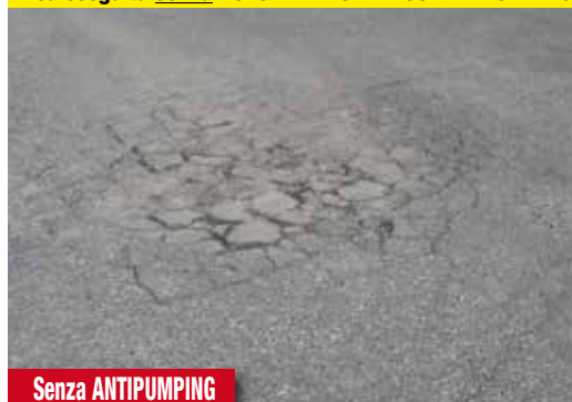
Area eseguita senza AUTOTENE ASFALTICO ANTIPUMPING
