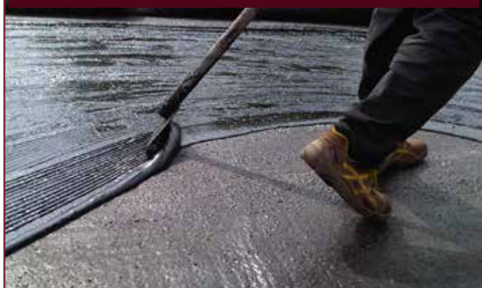
POSA DELL'ADESIVO MASTIPOL
