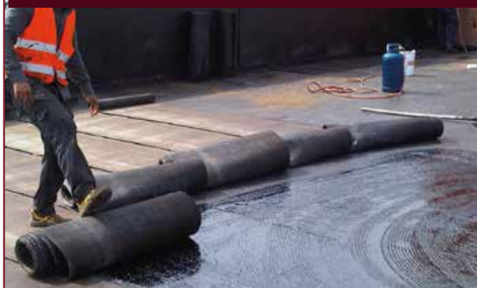
POSA DELLE MEMBRANE FLEXTER TEX
