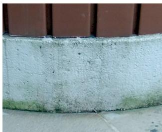
**2** Una volta pulita e sanificata la superficie, si procederà alla verniciatura con **SILICOLOR**, pittura acril-silossanica ad alta permeabilità al vapore acqueo e basso assorbimento d'acqua, contenente additivi ad ampio spettro per combattere la ricrescita dei microrganismi. In alternativa **EXTRAQUARTZ Paint** o **EXTRA Paint**, pitture lavabili ad elevata resistenza agli agenti atmosferici, contenenti additivi ad ampio spettro per combattere la ricrescita dei microrganismi.
