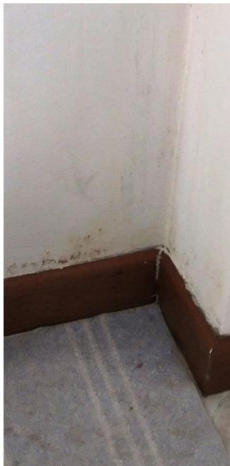
**2** Una volta pulita e sanificata la superficie, si procederà alla verniciatura con la pittura **DRYWALL**, speciale pittura con proprietà anticondensa ed antimuffa, in grado di combattere la ricrescita della muffa.
