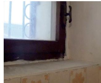
**2** Dopo la pulizia preliminare, ed il lavaggio con acqua, si procederà con un trattamento protettivo per prevenire una nuova formazione di muffe, mediante il prodotto sanificante ad ampio spettro d'azione **SANIPROTECT - IL BLOCCAMUFFA**, secondo le modalità indicate nella scheda tecnica.
