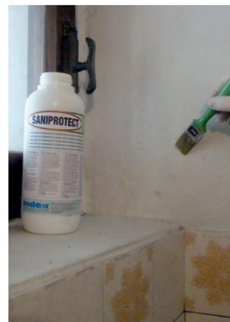
**3** Una volta pulita e sanificata la superficie, si procederà alla verniciatura con la pittura **DRYWALL**, speciale pittura con proprietà anticondensa ed antimuffa, in grado di combattere la ricrescita della muffa.
