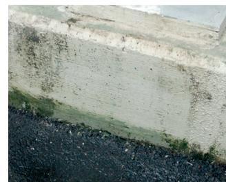
**2** Dopo la pulizia preliminare, ed il lavaggio con acqua, si procederà con un trattamento protettivo per prevenire una nuova formazione di muffe mediante il prodotto sanificante ad ampio spettro d'azione **SANIPROTECT - IL BLOCCAMUFFA**,
