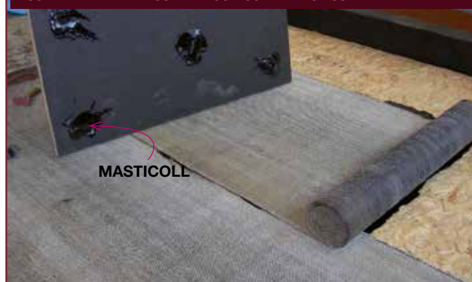
POSA DEI PANNELLI ISOLANTI CON COLLA MASTICOLL
