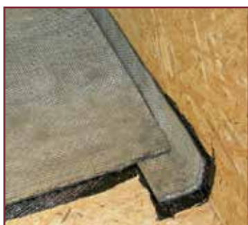
4. La membrana della parte piana, incollata con MASTIPOL verrà attestata al piede del rilievo saldandola alla fascia angolare
