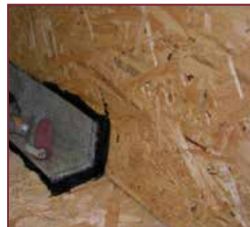
3. Si pressa accuratamente la fascia di rinforzo
