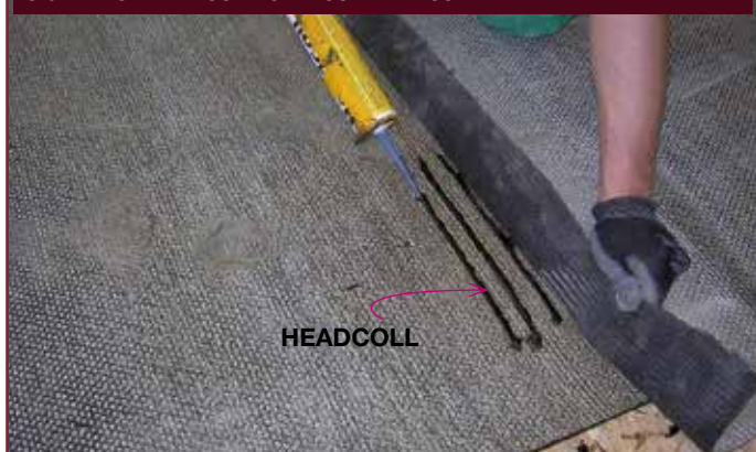
SIGILLATURA DEI SORMONTI CON HEADCOLL
